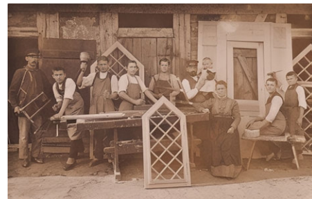
Tischlerei Hermann Edelmann 1910, Hauptstr., Bau der Fenster für die Friedhofskapelle
