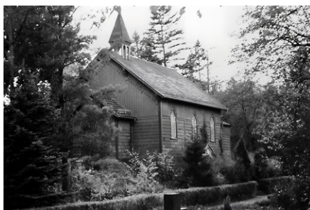
Friedhofskapelle mit Dachreiter, Blick von Nordosten
