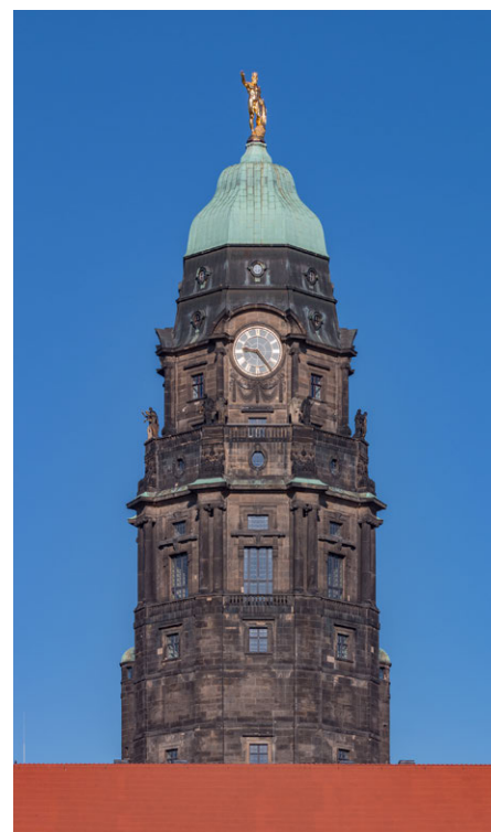
Rathausturm des Neuen Rathauses in Dresden
