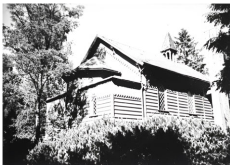
Friedhofskapelle - Seitenansicht, Blick von Südwesten
