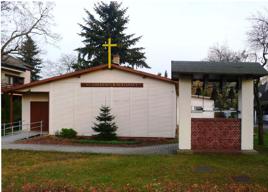
Notkirche St. Johannes M. Vianney (jetzt St. Franziskus), 1955 aus Holzfaserplatten errichtet Bildquelle: https://de.wikipedia.org/wiki/St._Franziskus_von_Assisi_(Berlin-Staaken)
